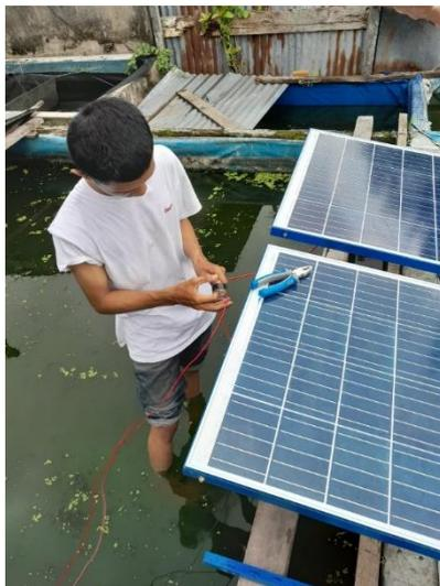
**Gambar 8.** Pemasangan solar panel
