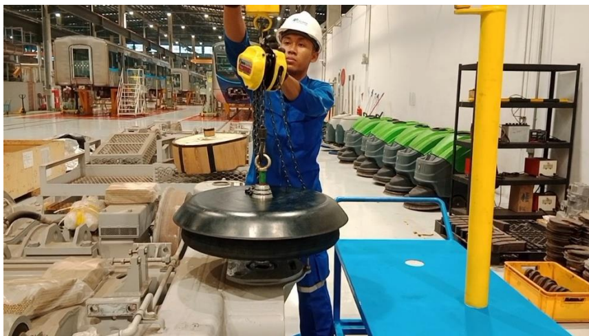
Gambar 12. Pemasangan air spring menggunakan alat crane trolley jig air spring
