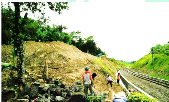
Gambar III.3 Titik rawan longsor (sumber : Dokumentasi Peneliti)
