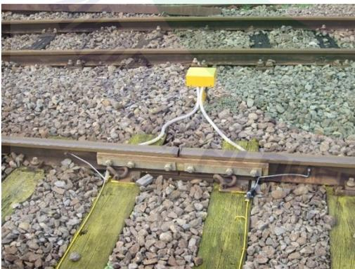
Gambar 1 Peralatan *Track Circuit*
