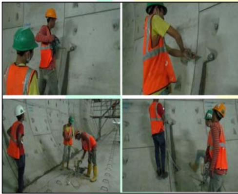
Sumber: dokumen pribadi Gambar 3 Proses Pekerjaan Grouting
